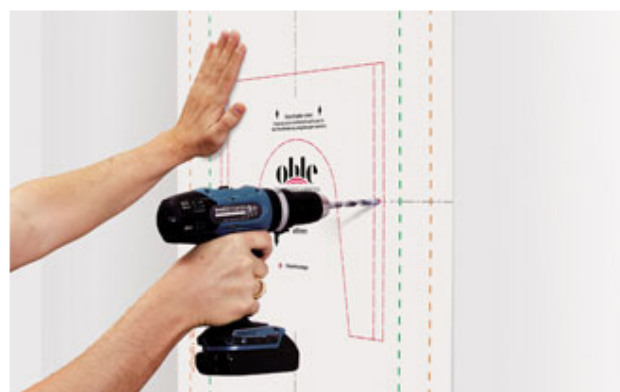
Montage der Infrarotheizung | © OHLE GmbH & Co. KG
